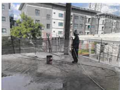
รูปที่ 49 ฉีดพรมน้ำบริเวณพื้นที่ก่อสร้างหรือบริเวณที่ทำให้เกิดฝุ่น
