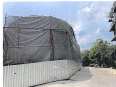
รูปที่ 59 ช่วงโครงสร้างอาคาร กำแพงกันเสียงสูง ประมาณ 3 เมตร และห่างจากตัวอาคาร 1 เมตร
