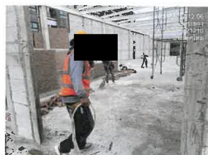
รูปที่ 49 ฉีดพรมน้ำบริเวณพื้นที่ก่อสร้างหรือบริเวณที่ทำให้เกิดฝุ่น
