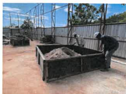
รูปที่ 48 บัน (Bund) สำหรับกองทรายในพื้นที่ก่อสร้าง
