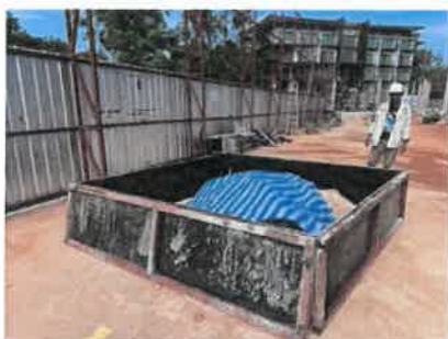
รูปที่ 48 บัน (Bund) สำหรับกองทรายในพื้นที่ก่อสร้าง
